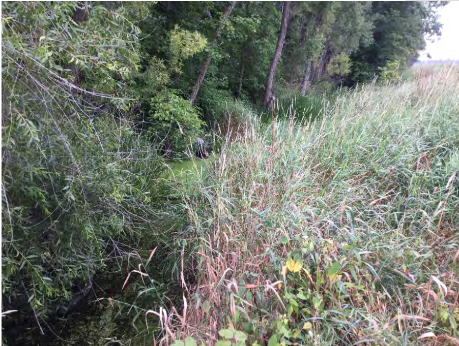
CSAH 3 looking east
